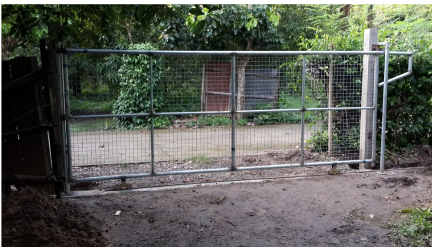
ภาพที่ ๒ ประตูบ้านแบบเลื่อนที่ผู้เขียนทำเอง
